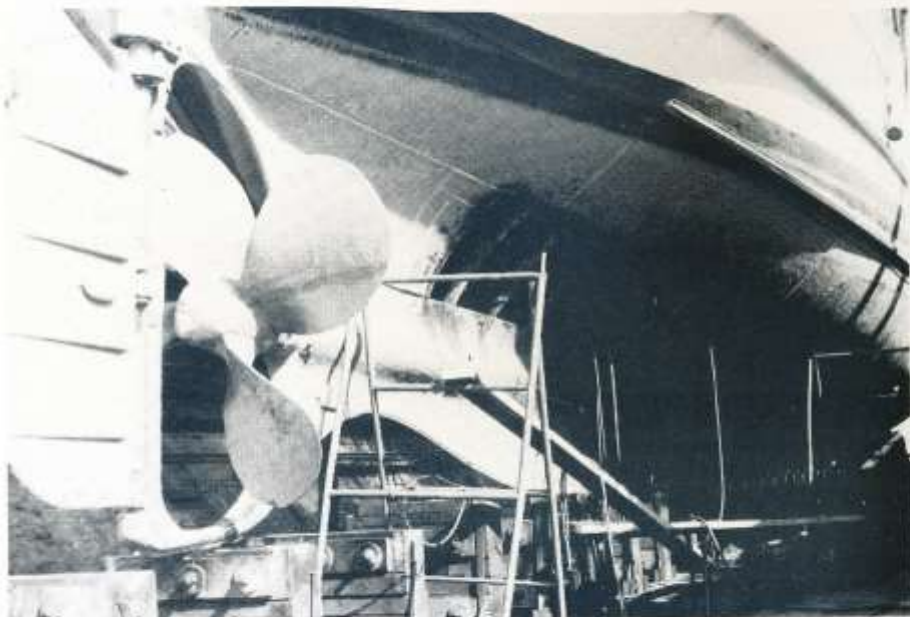
BOHUSLÄN i docka hos Roos & Hagström på Ringön. Här ser man hålet efter plåtarna som skurits bort för att ersättas med nya plåtar. Foto Gunnar Söderberg 13 april 1975.
